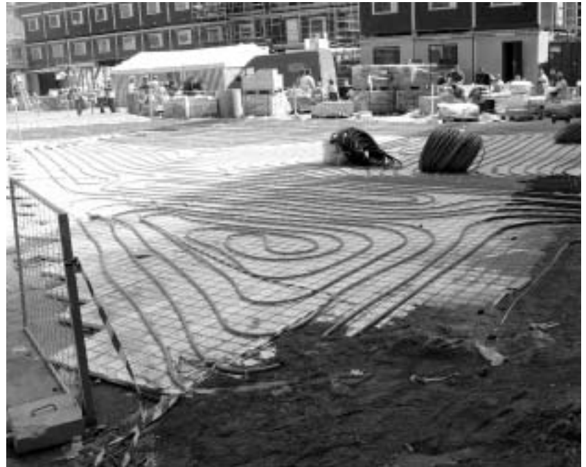
Eine Fußbodenheizung im Außenbereich des Busbahnhofs sichert auf insgesamt 2.000 Quadratmetern die Frostfreiheit des Bahnhofsvorplatzes. Für die begehbaren Flächen sind zehn Zentimeter dicke rote Granitplatten aus Finnland vorgesehen. Neben den Natursteinflächen wird es aber auch intensive Dachbegrünungen geben. Kleinteilige Areale des Platzes werden zum Verweilen anregen.
