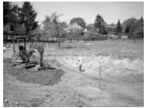
Nachdem die Mulde für die neue Teichlandschaft ausgehoben ist, wird der Boden mit zwei Lehmschichten abgedichtet.
