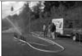
Das Rain Bird-Mobil vor Ort
